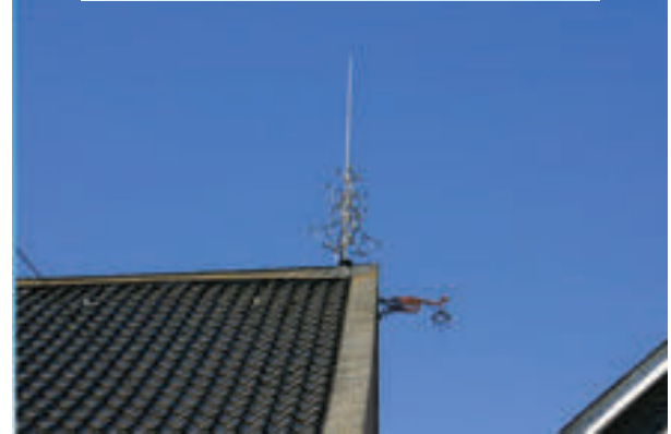
படம் 1.64 (அ) மின்னல் கடத்தியின் திட்ட வரைபடம் (ஆ) மின்னல் கடத்தி பொருத்தப்பட்ட ஒரு வீடு
