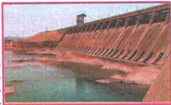
Fig.- 3.2 Hirakud Dam
