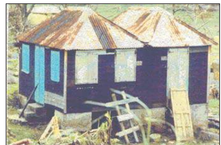
चित्र 1. यदि प्राकृतिक रूप से ऊंचाई वाला स्थान उपलब्ध न हो तो खंभों पर या मिट्टी के कृत्रिम टीलों पर निर्माण करना
