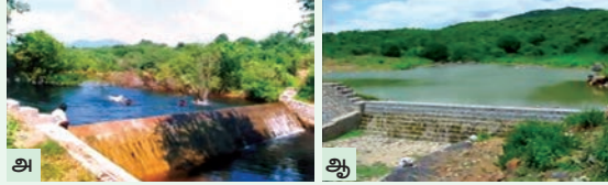
படம் 8.4: TAP திட்டத்தின் கீழ்க் கட்டப்பட்ட கட்டுமானங்கள் அ. தடுப்பணை ஆ. வழிந்தோடும் குளம்
