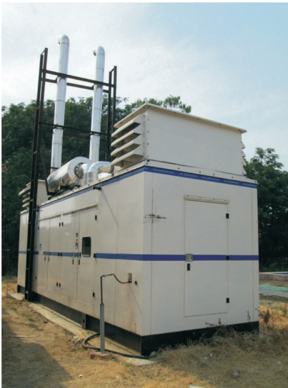
Fig.12.6. Diesel generator set
