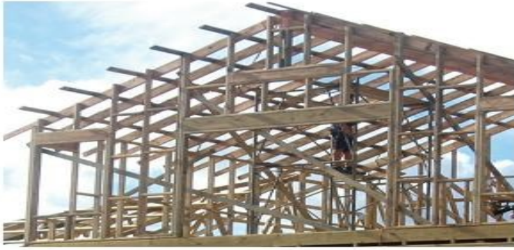
एक भवन निर्माण
